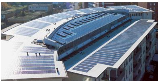
Dünnschicht-PV-Dachbahn, Foto: Alwitra
