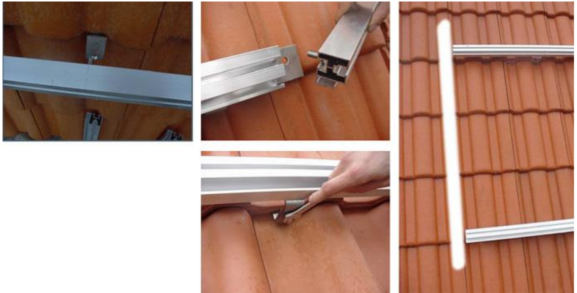
Verlegen der Montage-schienen – Foto: Schletter Solar Montagesysteme
