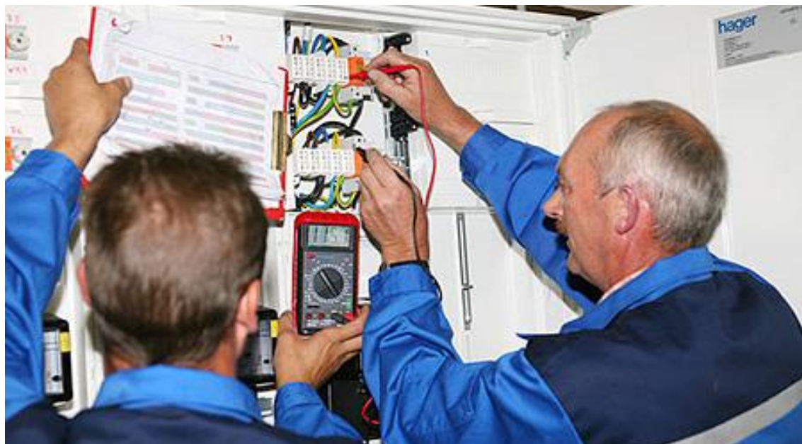
Wartung eines Wechselrichters, Foto: G.A.I.A. GmbH
