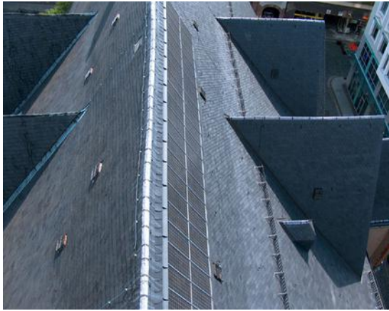
Die PV-Anlage auf dem Dach der denkmalgeschützten Nikolai-Kirche in Leipzig ist für den Betrachter von unten fast „unsichtbar“. Foto: C.Hilgers
