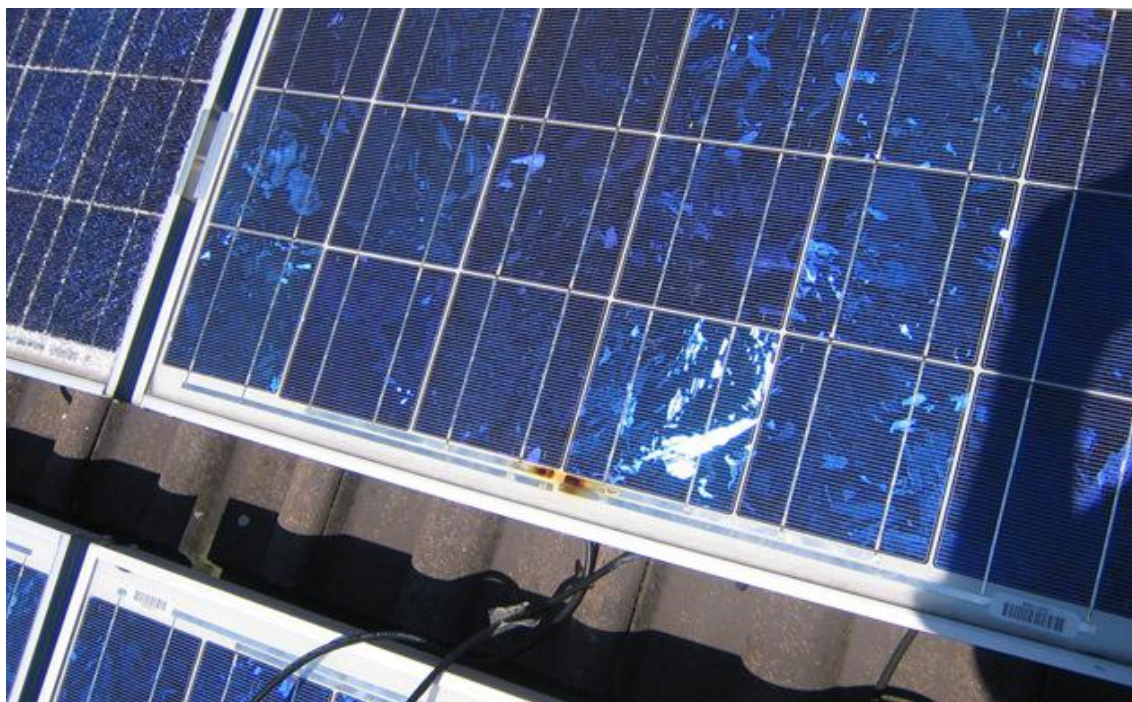
Blitzschaden bei PV-Anlage - links: gesprungenes Glas durch thermische Einwirkung, rechts: Schmauchspur im Bereich der Bypass-Diode Foto: photovoltaikbuero Ternus & Diehl GbR
