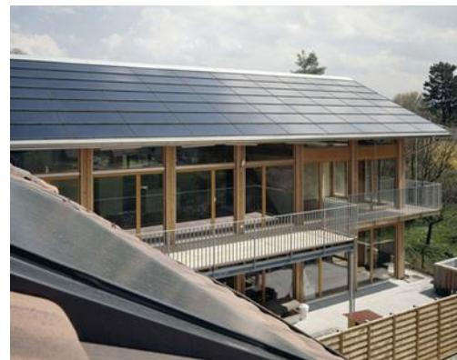
Komplett-Dach mit Modulen, Foto: Ernst Schweizer AG, Metallbau
