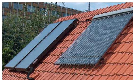
Aktive Solarnutzung mit Sonnenkollektoren
