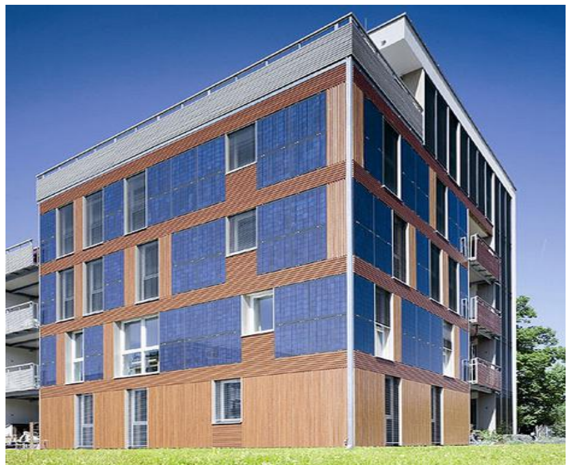
Solarfassade am Nullenergiehaus, Foto: Sunways AG
